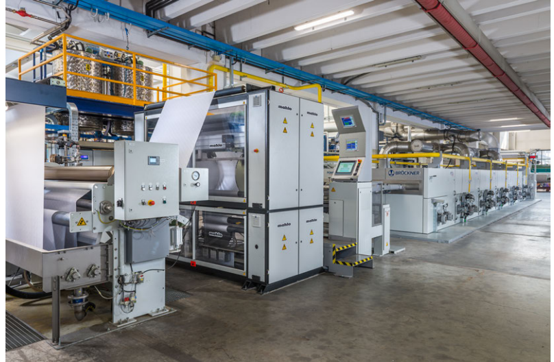
Impianto combinato Mahlo con Orthomax RFMB e controllo del processo Optipac VMC su una rameuse di finissaggio.
