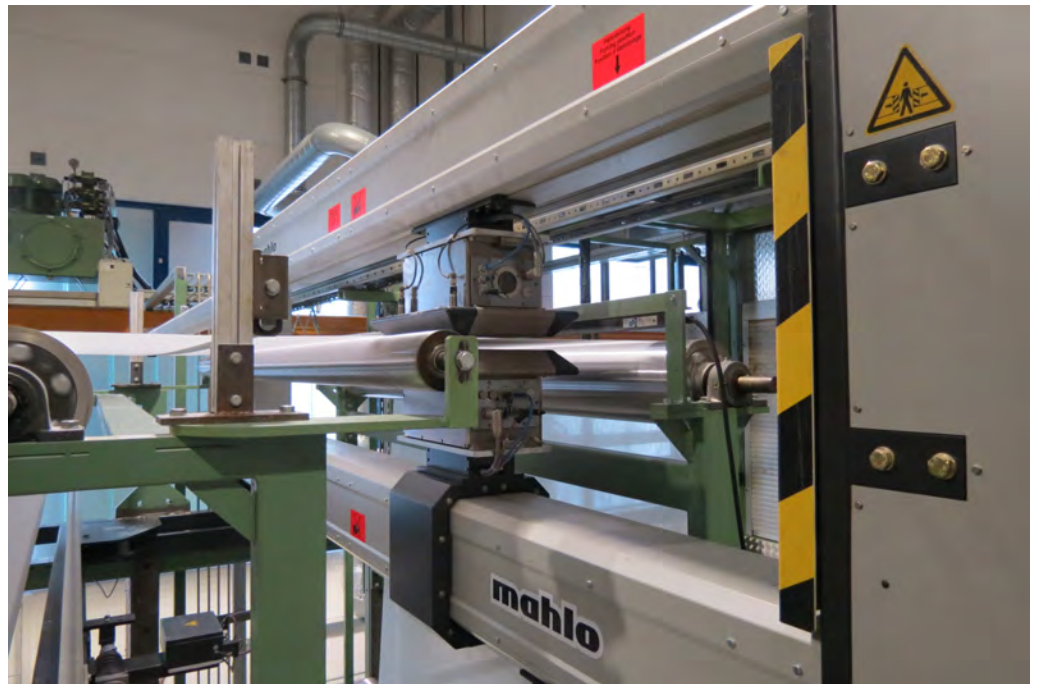
Abb. 3: Installation eines Gravimat DFI bei Kirson Industrial Reinforcements GmbH
